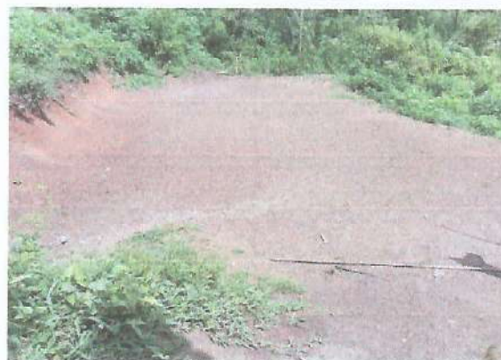
Foto 2: LOSA DE PATIO
